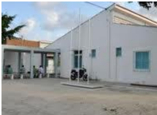
Figura 1: Fachada da frente da escola José Lins
