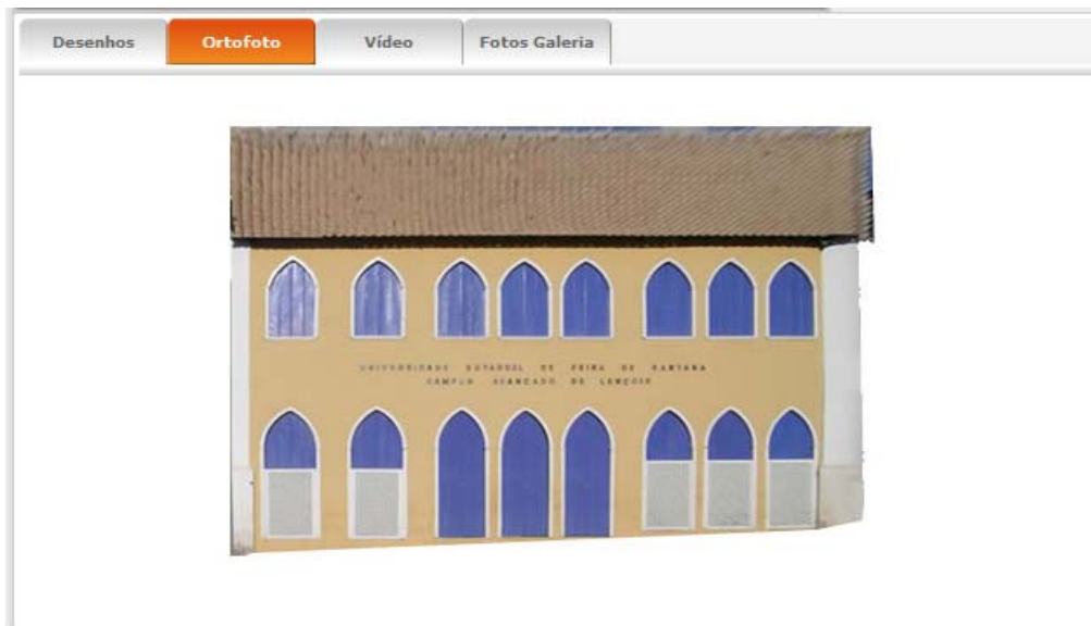
Figura 2: Ortofoto do Campus Avançado de Lençóis da Universidade Estadual de Feira de Santana - UEFS.
