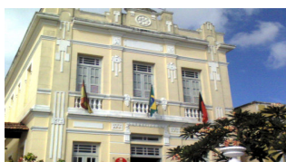
Figura 2- Hotel Globo (depois da restauração). Foto: J. Soares, 2007.
