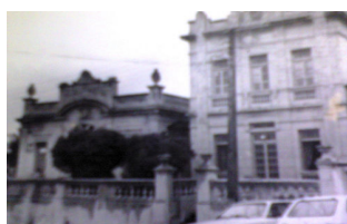
Figura 1 – Residência do Sr. Henrique Siqueira – Acervo IHGP Foto: Walfredo Rodriguez (Séc. XX)
