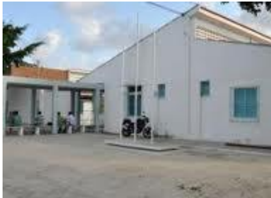
Figura 1: Fachada da frente da escola José Lins
