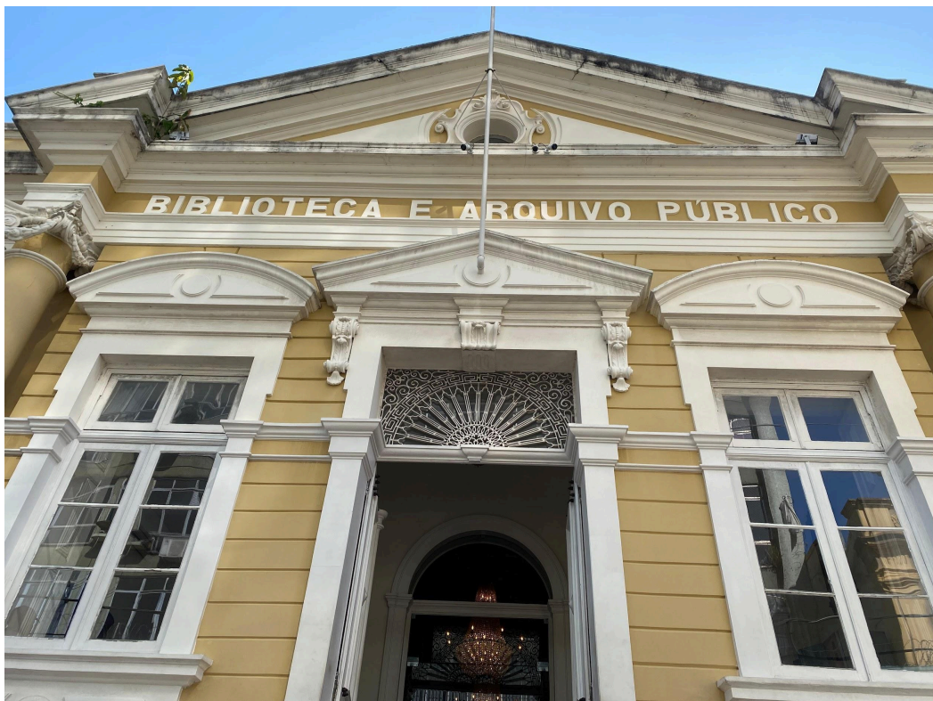
Imagem 1: Fachada do Arquivo Público do Estado do Pará – APEP. Fonte: acervo pessoal.
