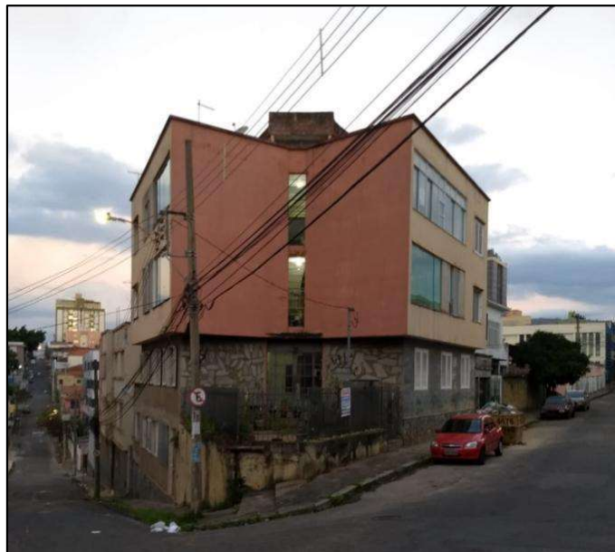
Figura 2: Prédio da Rua Bueno Brandão
