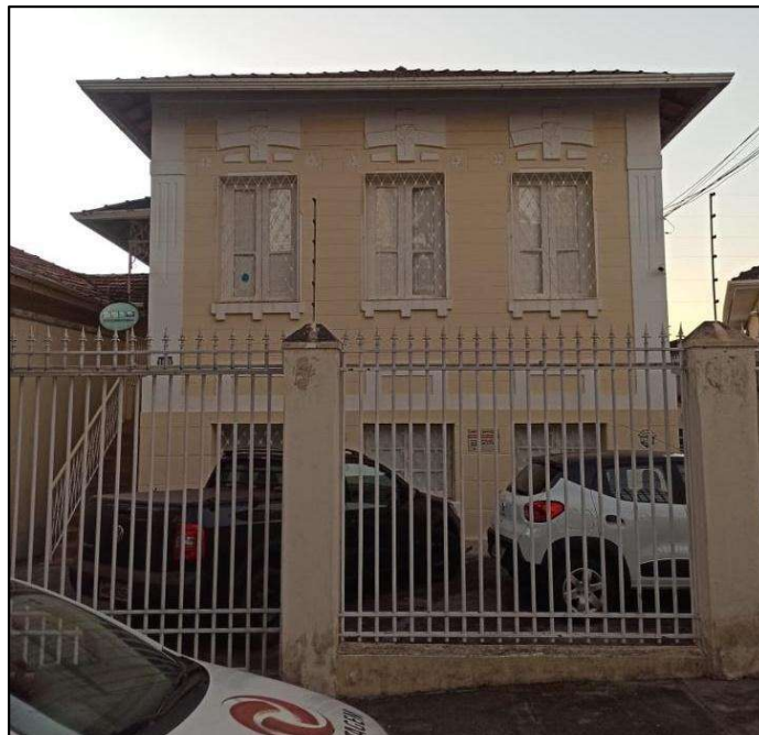
Figura 3: Residência Leandro da Silva Perdigão
