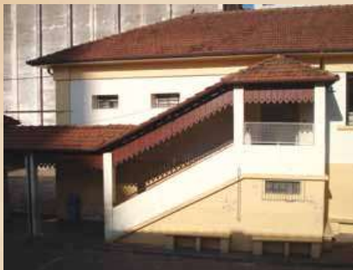
Escadaria interna que dá acesso ao pátio. (Fotografia de Sônia Conceição Devidé Minucci e Fabiano da Rocha)
