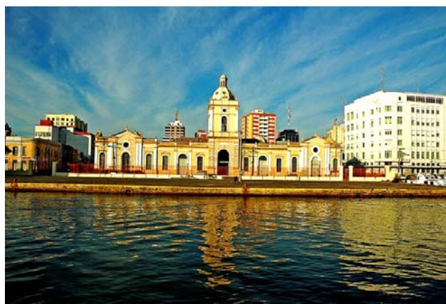
Figura 2: Terceiro Prédio da Alfândega
