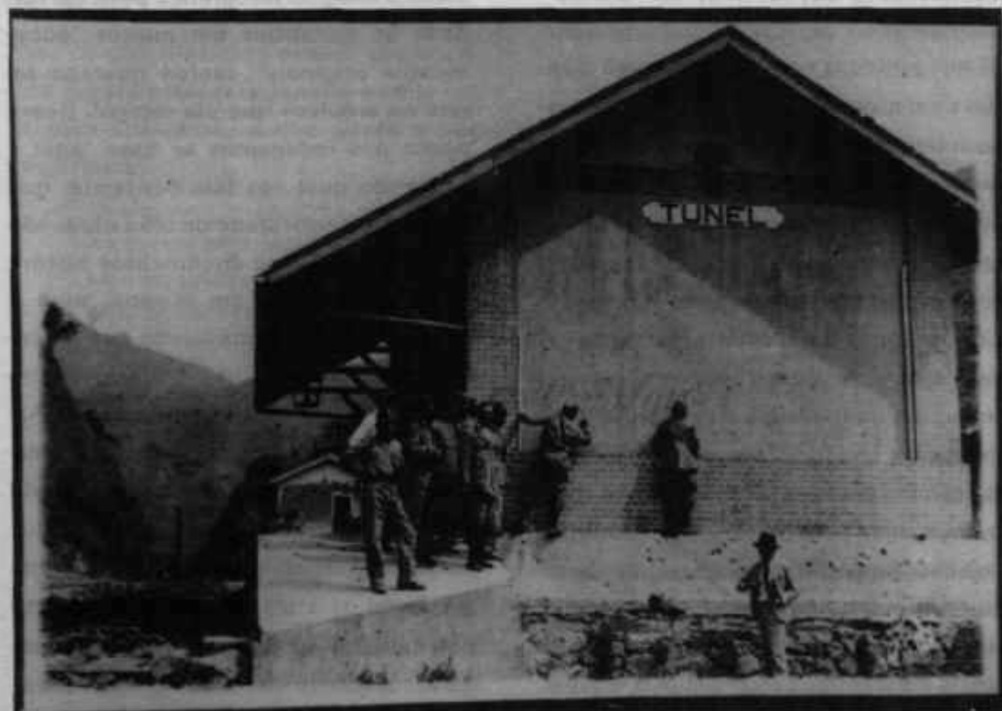
Estação do Túnel, no momento em que foi ocupada pelas forças mineiras. O major Albergaria, com carvão, muda o nome da estação para 'Cel. Fulgêncio'. (Legenda da foto publicada na revista Careta , ano 25, n° 1.267, 1° de fevereiro de 1932) FGV/CPDOC/ Arquivo Gustavo Capanema.
