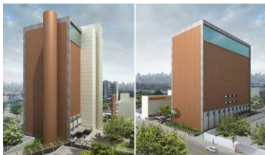
Figura 2: Estrutura do Edifício do APESP – Placas de metal
